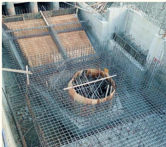
導水裝置安裝
