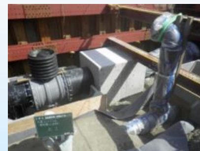
スラストコンクリート見本 ※明翫組
