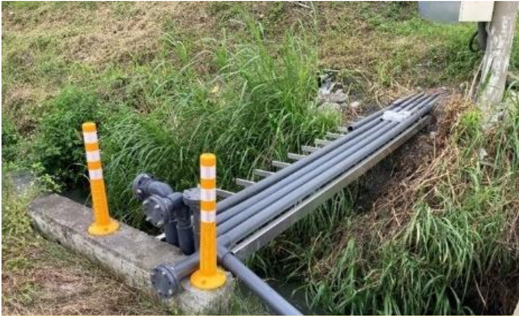
管線掛管於渠道上方
