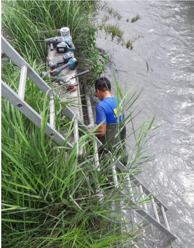
廠外管線補強
