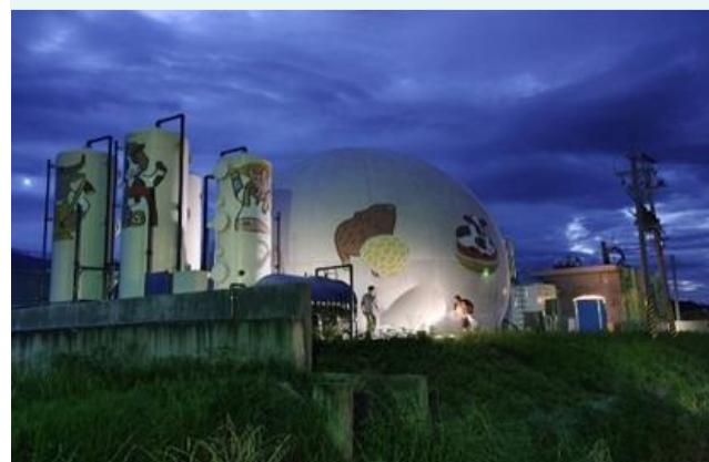
生質能源中心夜景
