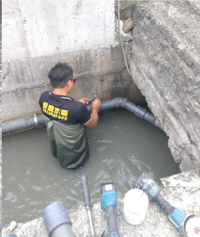
廠外管線補強
