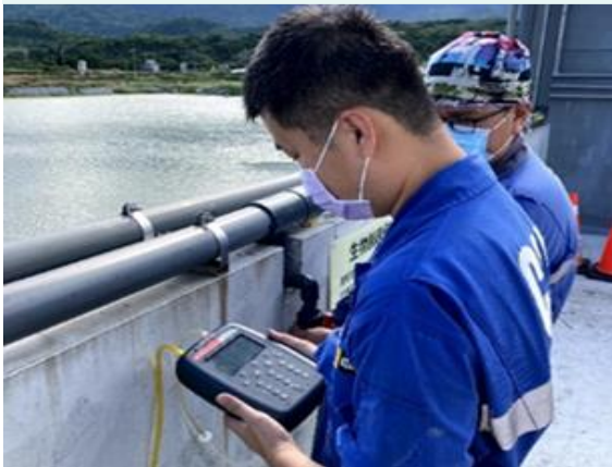
厭氧消化槽沼氣品質自主檢查
