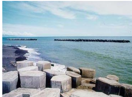
防洪工程 (河堤及海堤興建)
