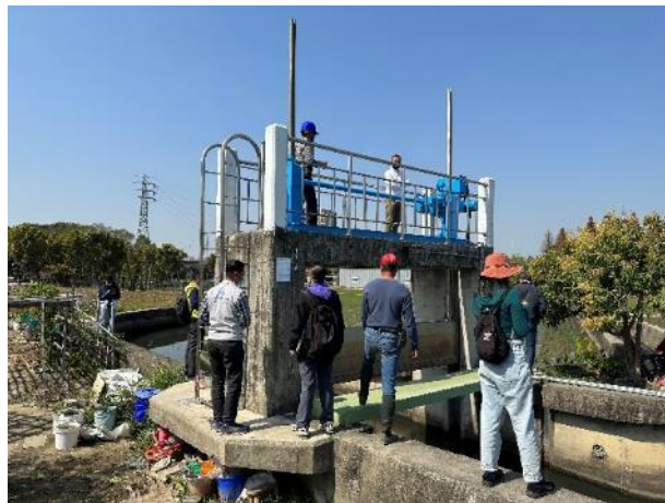
臺中管理處中和排水閘門
