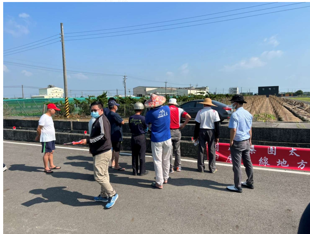
第二次 施工現場
