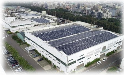
桃園市鋼鐵工廠 1.8MW
