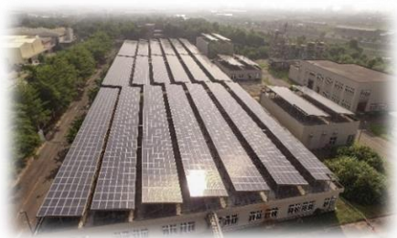
高雄市本洲工業區淨水廠 1.4MW
