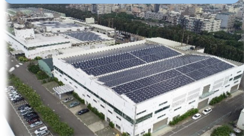
桃園市鋼鐵工廠1.8 MW
