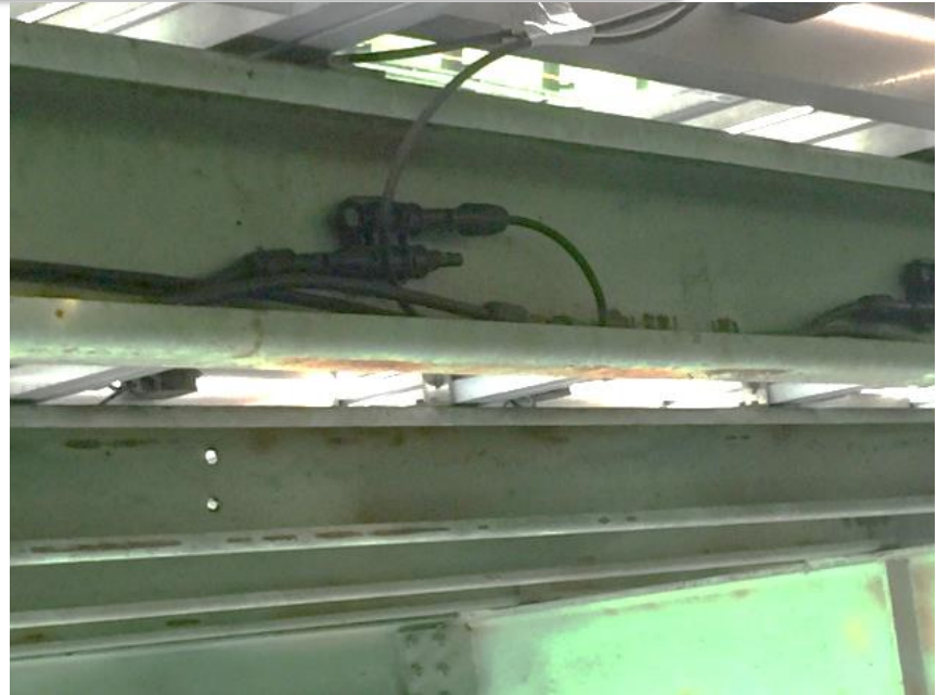
串列串併方式使用錯誤
