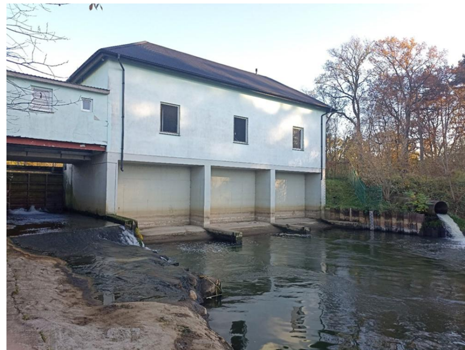
Bukowina Bobrzańska 小型水力發電廠 該發電廠安裝Kaplan-1550渦輪機
